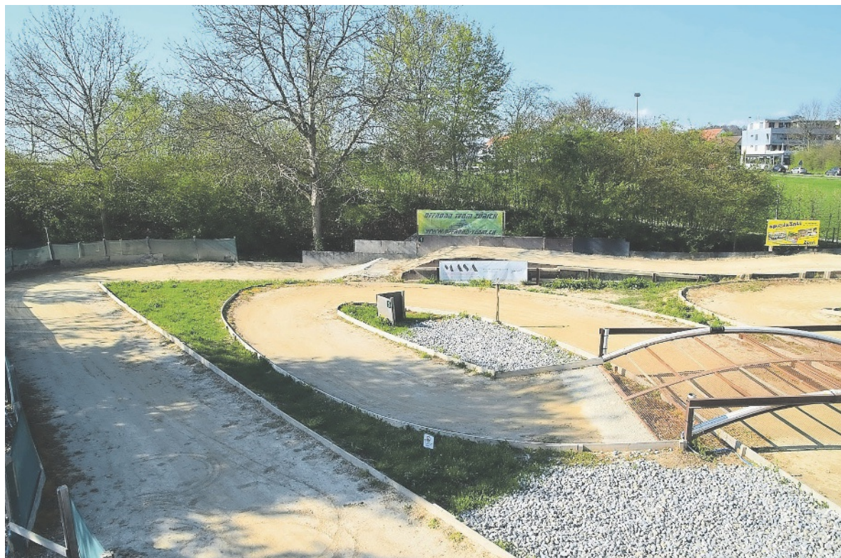
Blick auf das Renngelände des Offroad-Teams Zürich: Die Gemeinde beteiligt sich an den Kosten für einen Stromanschluss. BILD ZVG
