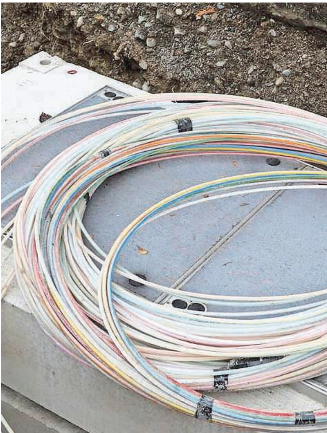
Volketswil soll flächendeckend mit einem Glasfasernetz ausgerüstet werden.
