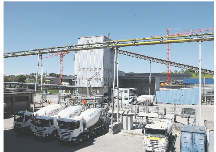
Auf dem Gelände der Hastag wird auch Beton hergestellt. Hier die Wasch- strasse für Lastwagen, so genannte Fahrmischer, am Ende des Arbeitstages.
