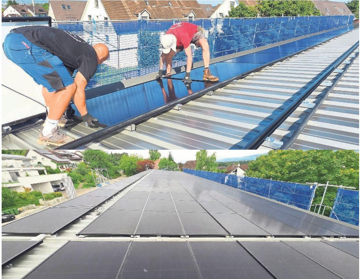
Die Solarpanels wurden Ende August auf dem Dach der Dorfschule Gutenswil installiert. Die Anlage produziert rund 100'000 Kilowatt Strom pro Jahr.
