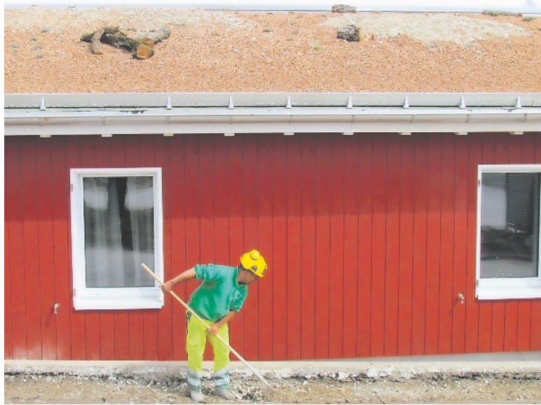
Blick von aussen auf die «Bereuter-Lodge»: Das Dach ist mit Ziegelschrot und Komposterde bestückt, um Biodiversität zu ermöglichen.
