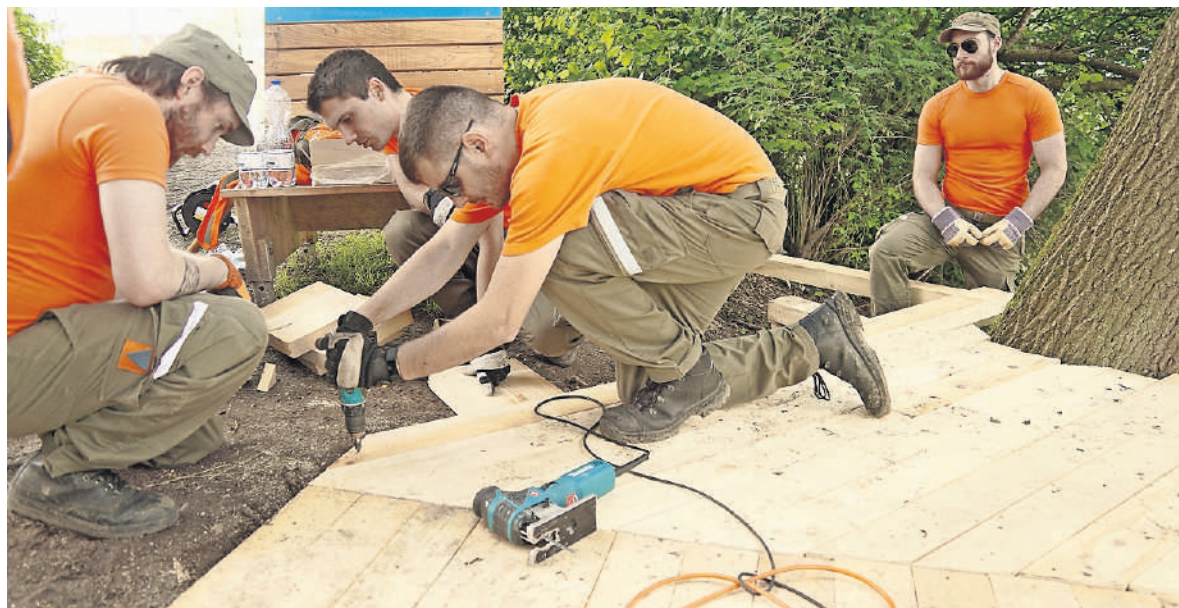
Der Zivilschutz muss aufrüsten: Für die Erneuerung der EDV, des WLAN sowie der Elektroanlage im Kommandoposten bewilligt der Gemeinderat Geld. BILD ZVG
