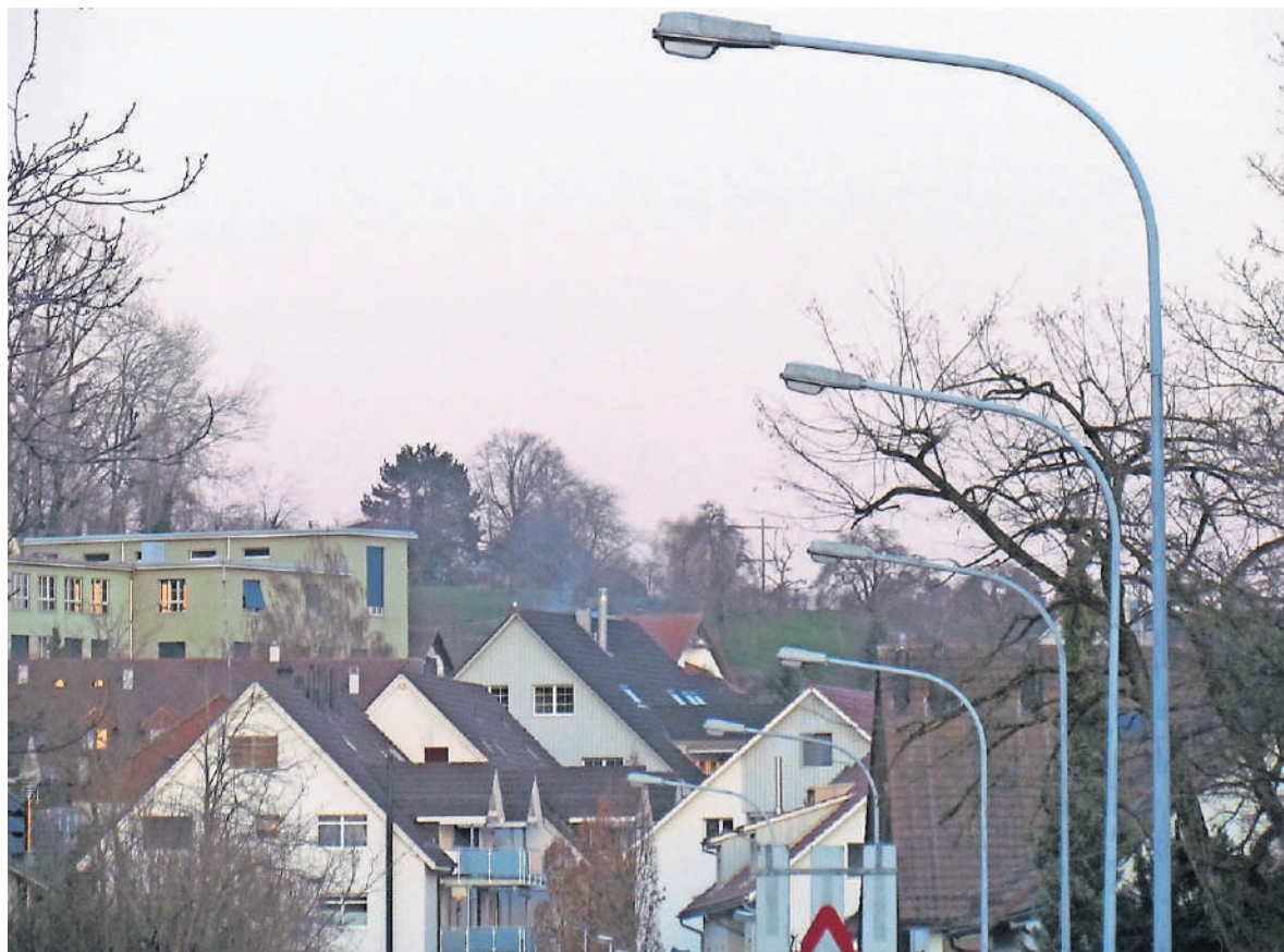
Gemeinderat hat Kredit bewilligt: Die Kandelaber entlang der Austrasse sind inzwischen über 40 Jahre alt und müssen ersetzt werden.
