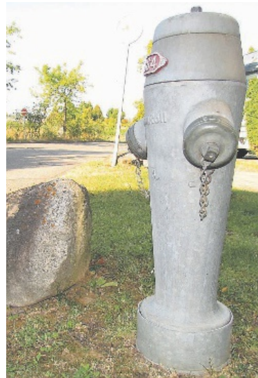
Leitungsersatz: Hydrant an der Kanalisation zwischen der Brunnenstrasse und der Schwerzenbachstrasse. BILD RBÜ
