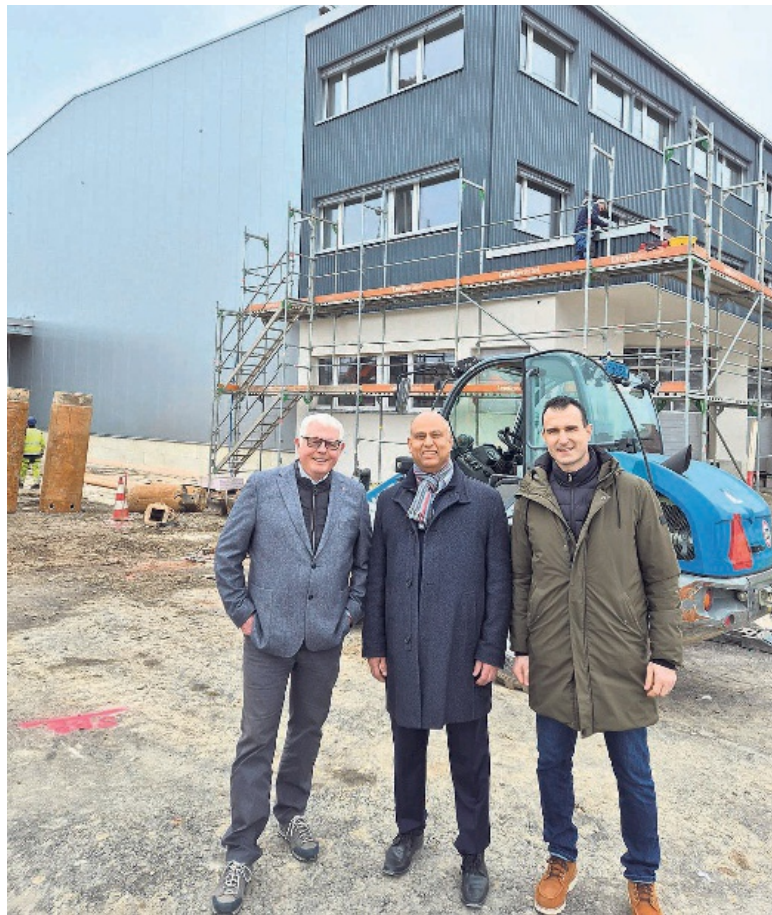
Dominik Rieder (VR-Präsident), Jean-Philippe Pinto (Gemeindepräsident) und Antonio Rizzello (COO) auf der Baustelle in Volketswil (v. l.).
