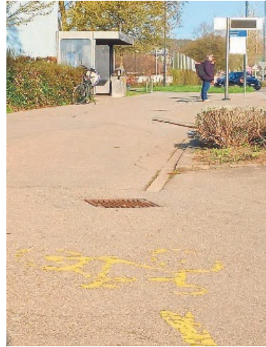
Der Veloweg, welcher mitten durch die Bushaltestelle Zentrum führt, findet eine Volketswilerin gefährlich – der Gemeinderat verspricht Besserung. BILD TSP
