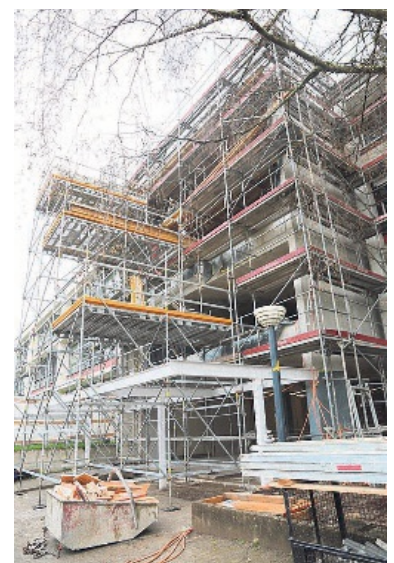
Über dem Haupteingang sieht man bereits die neuen Räume im Rohbau.
