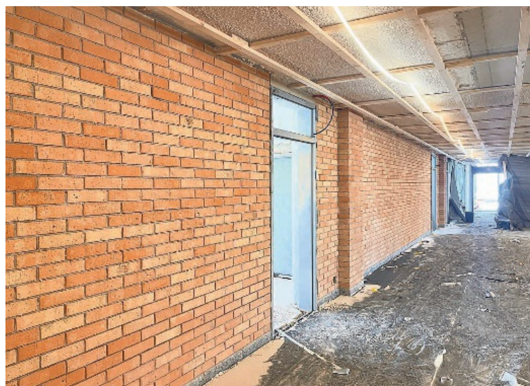
Die übermalten Backsteinmauern wurden sandgestrahlt und zeigen sich nun wieder in ihrem ursprünglichen Zustand.
