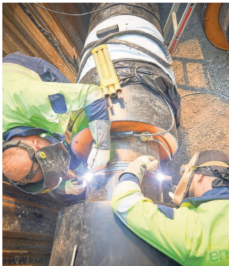
Die Leitungen, die für das neue Fernwärmenetz verlegt werden, sind mit rund 60 cm deutlich dicker als bei anderen Projekten. Das Ausmass illustriert die Grösse des Verbunds und damit auch das Potenzial der Abwärme als Energiequelle. BILD ENERGIE 360
