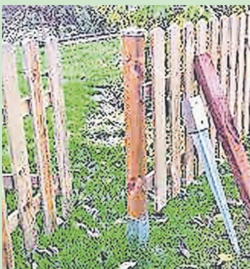
Zaun aus fertigen Elementen.
