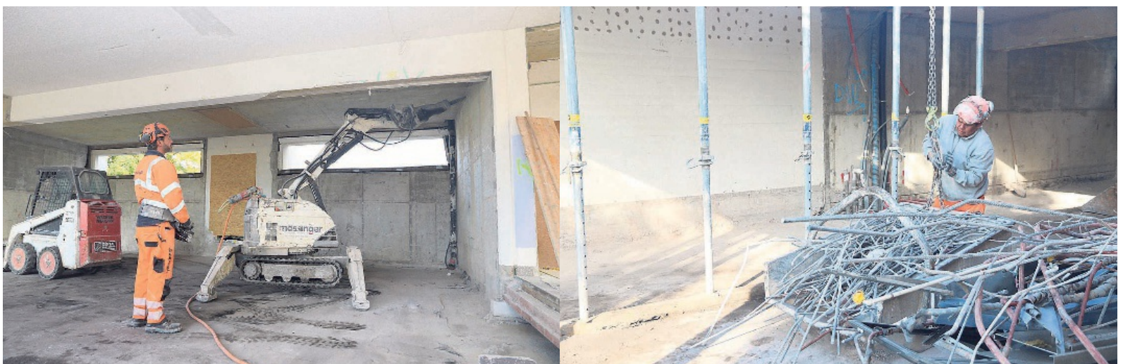
Im vierten Stockwerk des Südtrakts laufen die Abbrucharbeiten sowie die Vorbereitungen für das neue, zentrale Treppenhaus.
