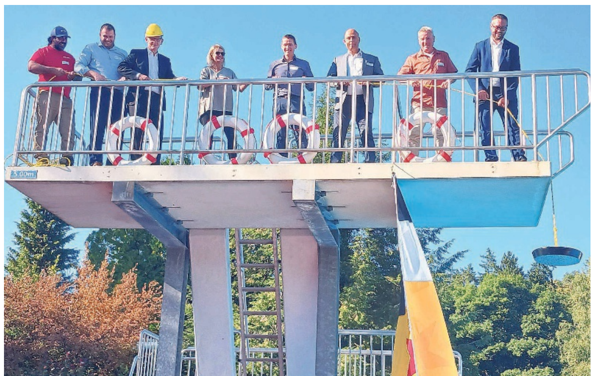
Da ein «Spatenstich» im Wasser relativ schwierig ist, wurde der Baustart stattdessen mit einem Stöpselziehen eingeleitet.
