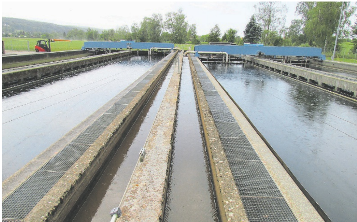
Mit einem Anteil von neu 50,8 Prozent ist Volketswil nach wie vor der grösste Nutzer der Kläranlage Bachwis in Fällanden.
