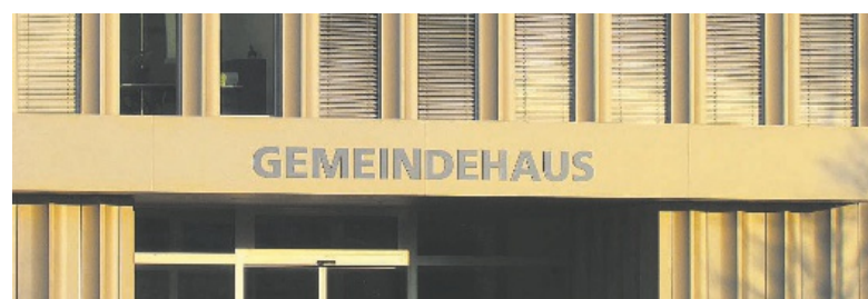
Während fünf Tagen wird das Erdgeschoss des Gemeindehauses umgestaltet.
