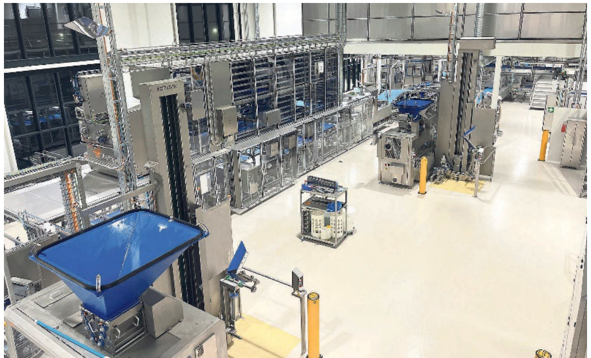
Blick in die neue Produktionshalle «B»: Aktuell werden hier bereits die ersten Kleinbackwaren hergestellt.
